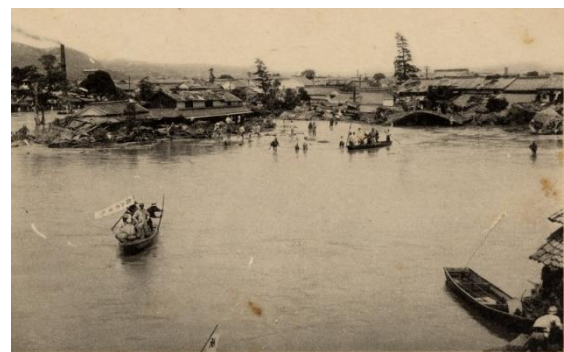
芦田川堤防決壊口（広島県福山市古野上町付近）
